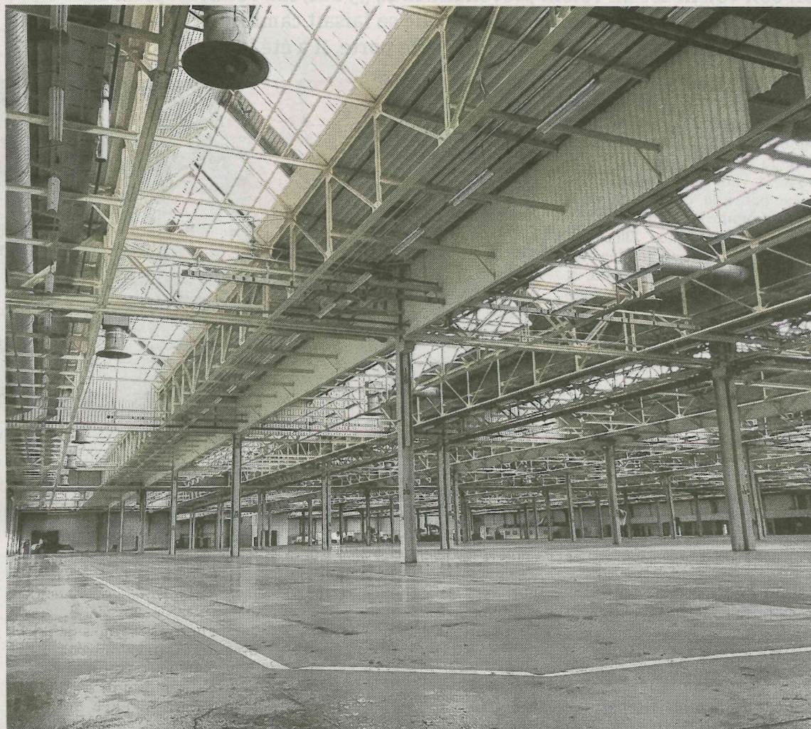
Il est situé au sud de l'emprise foncière, face à la piste de karting, à côté de l'étang, et jouxte la parcelle vendue en 2015 à Atlantic.
