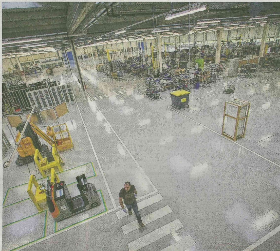
Atlantic produit des chaudières et des pompes à chaleur depuis février à Billy-Berclau. PHOTO ARCHIVES SEVERINE COURBE
