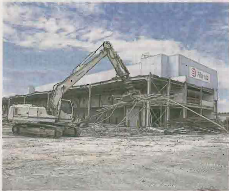
Débutée en juillet, la démolition devrait être terminée en décembre.
