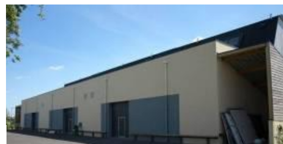
Façade Nord du bâtiment
