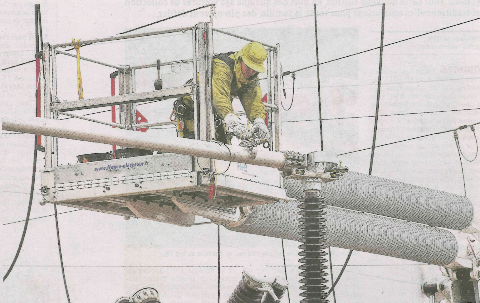
Sébastien est équipé d'une combinaison spécifique pour travailler sur une installation alimentée par du courant à 225 000 V. PHOTOS SÉBASTIEN JARRY
