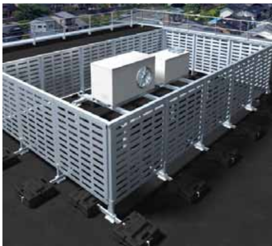
Exemple : équipements cachés derrière un plénum technique
