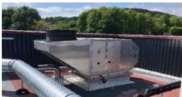
Exemple : équipements cachés par la remonté de l'acrotère.
