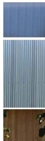
Exemple de bardages adaptés à la séquence d'entrée : panneaux polycarbonates, bois et aciers (motif bardage vertical)
