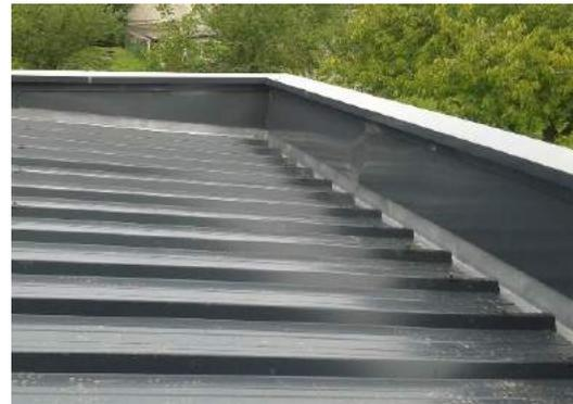
Exemples si la pente de la toiture est inférieure à 12%.
