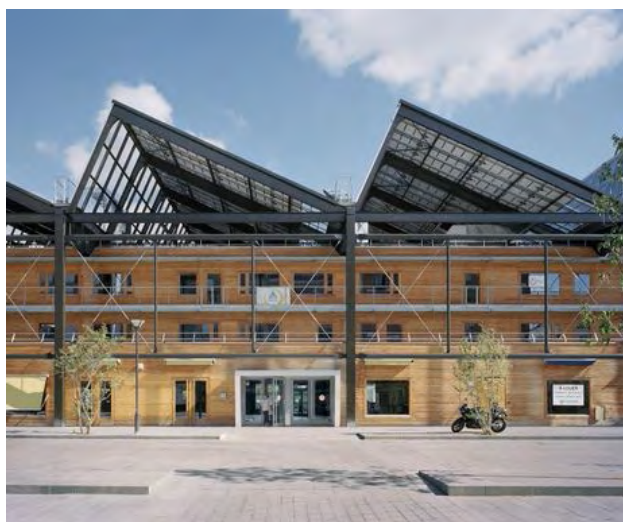
Exemple : interprétation des toitures sheds
