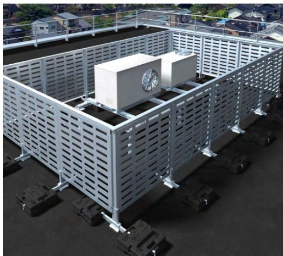
Exemple : équipements cachés derrière un plénum technique
