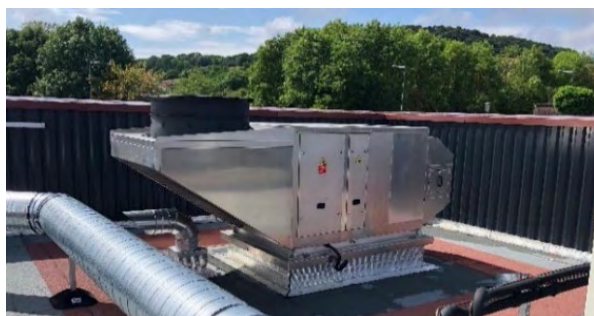
Exemple : équipements cachés par la remontée de l'acrotère.
