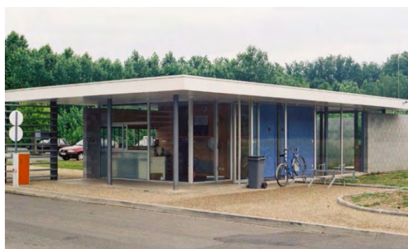
Poste d'accueil Usine POLYREY de Couze LALINDE
