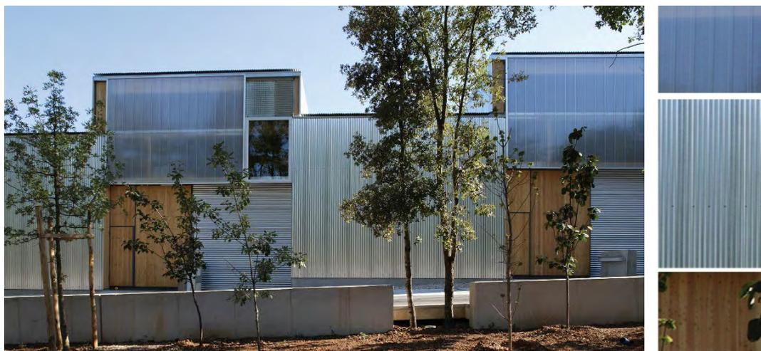
*Exemple de bardages adaptés à la séquence d'entrée : panneaux polycarbonates, bois et aciers (motif bardage vertical)*
