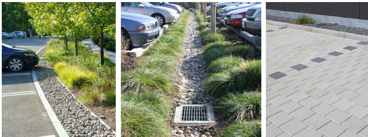
Exemples d'ouvrages de tamponnements étanches et traitements des stationnements pavés
